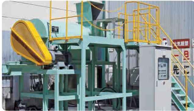
堆肥工場に設置 (MMS-800)
